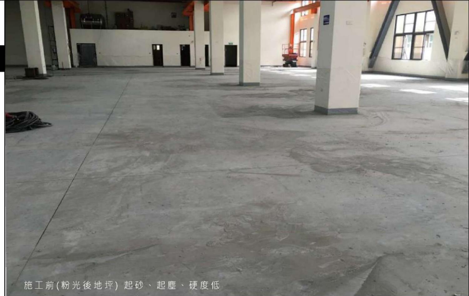
施工前(粉光後地坪) 起砂、起塵、硬度低
